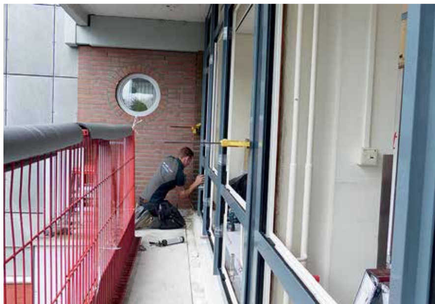
Voor deze gevelrenovatie zijn de profielen van Schüco gebruikt.
