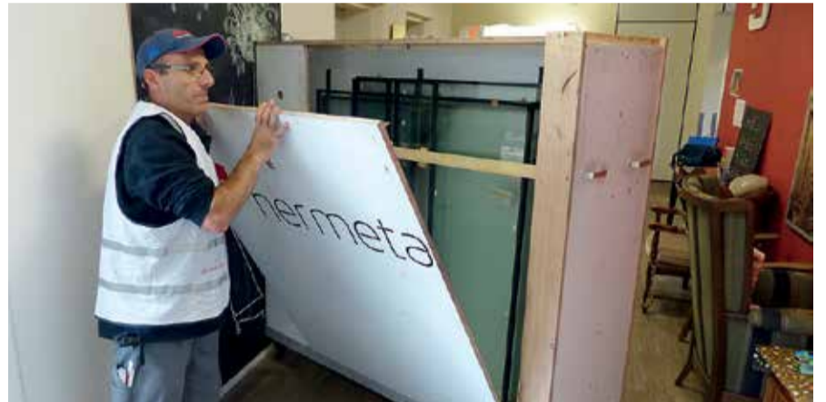
Eén van de elementen die Hermeta Gevelbouw speciaal voor dit project heeft ontworpen, is de transportkist. Deze bestaat uit twee afzonderlijke delen: de ene kant is bedoeld om het oude glas in af te voeren. Uit de andere kant van de kist komt het nieuwe glas er uit om geplaatst te worden in de nieuwe gevel.
