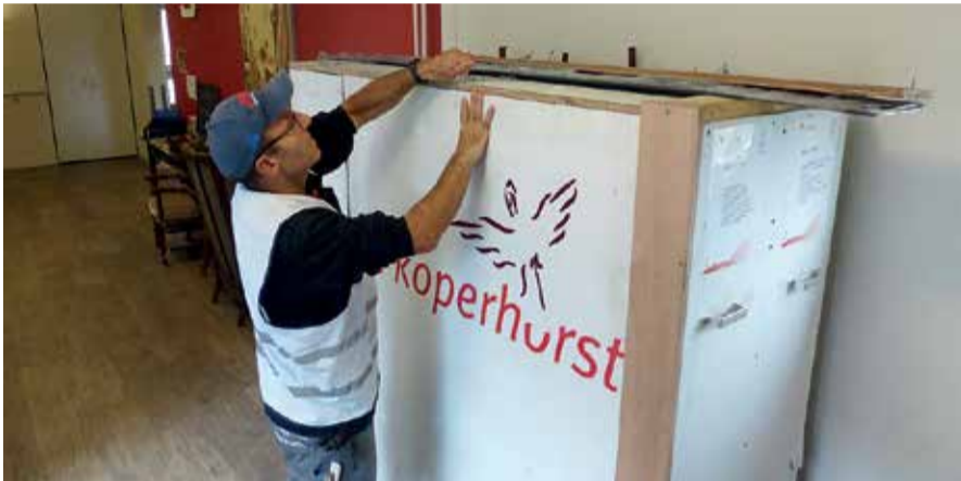
Eén van de elementen die Hermeta Gevelbouw speciaal voor dit project heeft ontworpen, is de transportkist. Deze bestaat uit twee afzonderlijke delen: de ene kant is bedoeld om het oude glas in af te voeren. Uit de andere kant van de kist komt het nieuwe glas er uit om geplaatst te worden in de nieuwe gevel.
