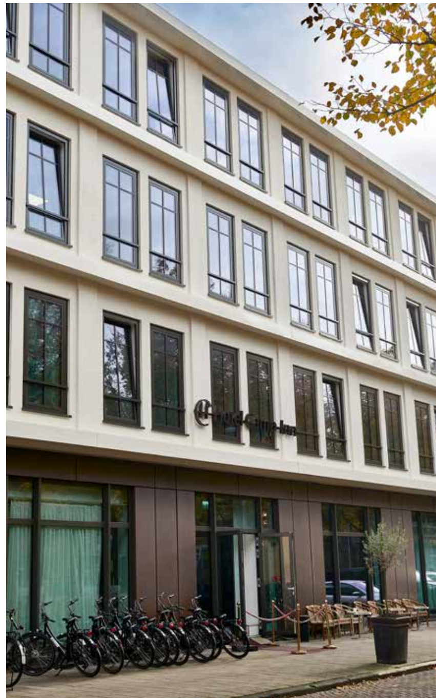
In het pand bevindt zich onder andere een hotel, dat tijdens de renovatie open bleef.
