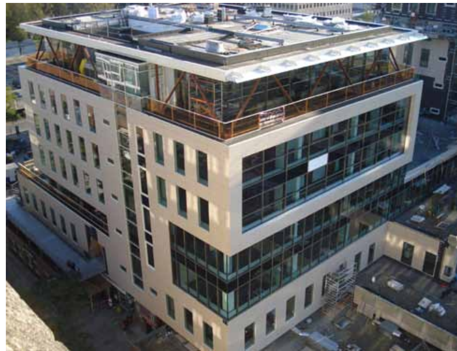
HSB bekleedt met keramische tegels.
