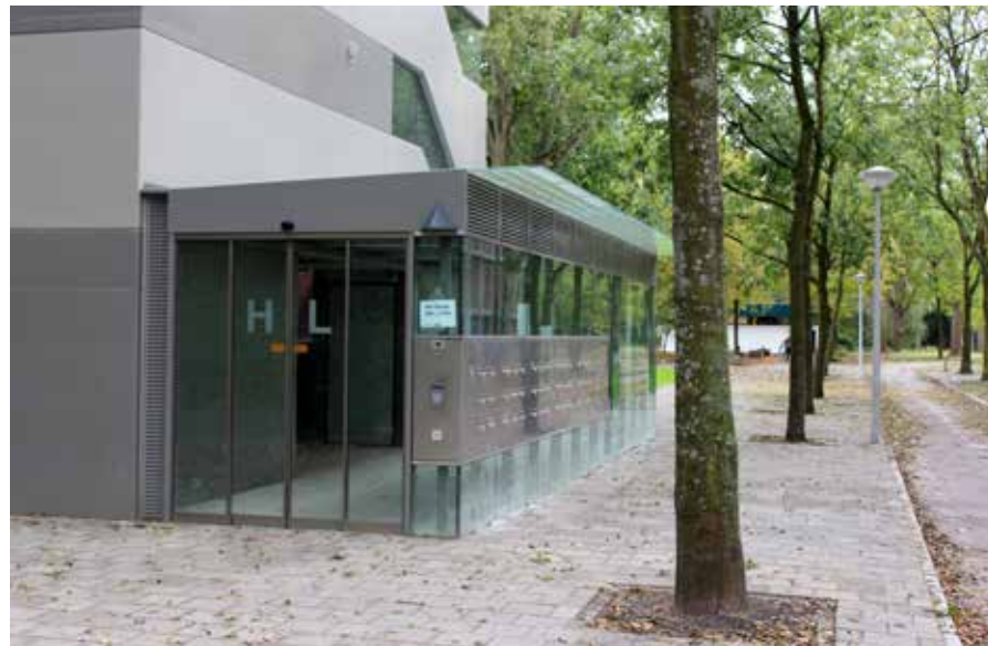
De glazen entreehuisjes bij elke flat geven de bewoners een veilig gevoel
